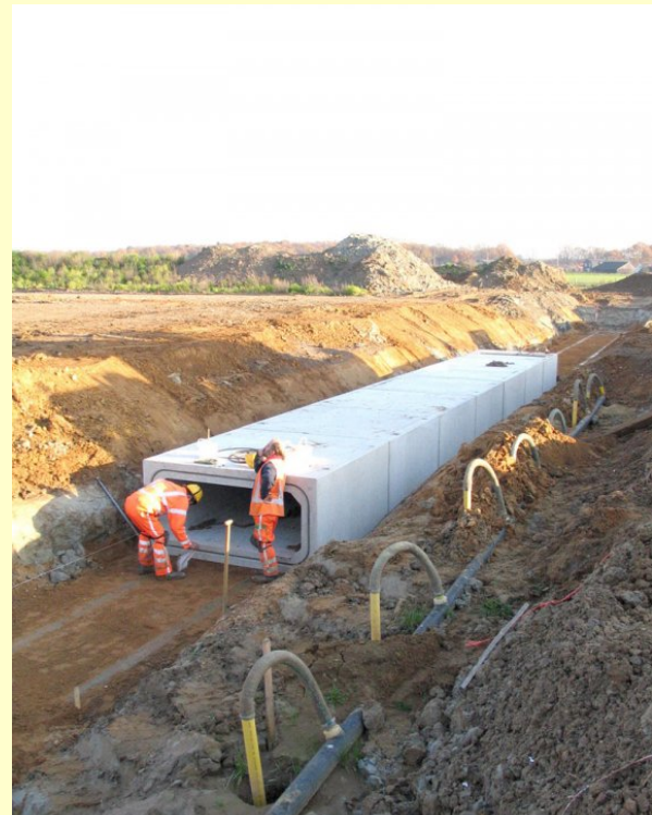
Aanleg ‘innovatieve’ faunatunnel bij viaduct Asenray in het traject van de A73
