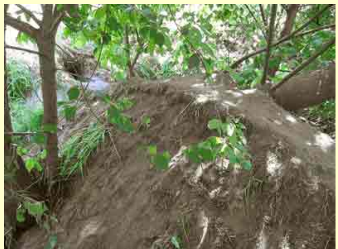
Hoge stortberg in de greppel naast het spoor
